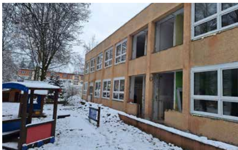
Začala sa komplexná rekonštrukcia MŠ Požiarňa 1292
