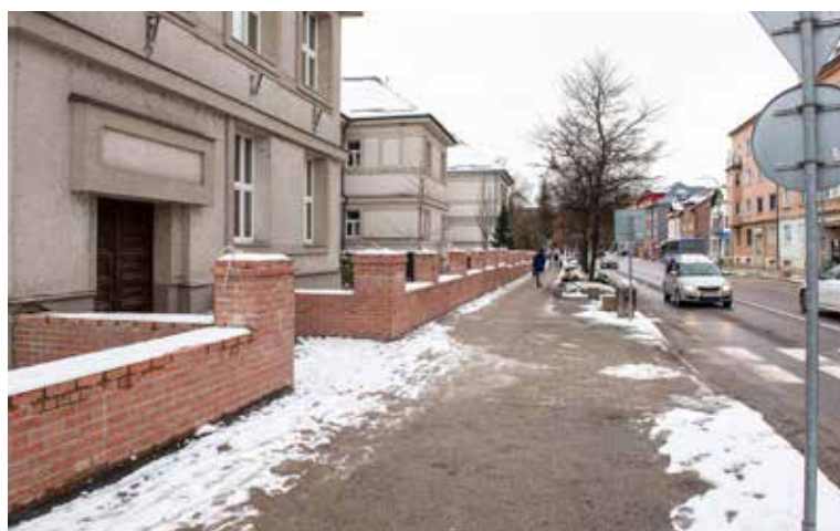
TSK - realizácia obnovy oplotenia gymnázia
