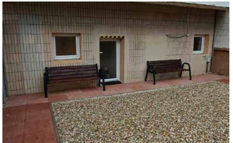
Úprava vonkajšieho priestoru pred saunou na krytej plavárni
