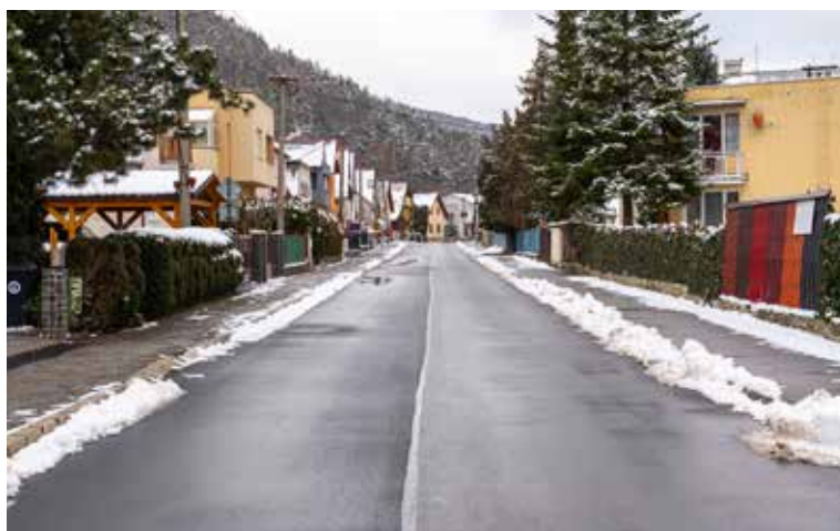
Opravené komunikácie na uliciach Janka Kráľa, Svätoplukova ...
