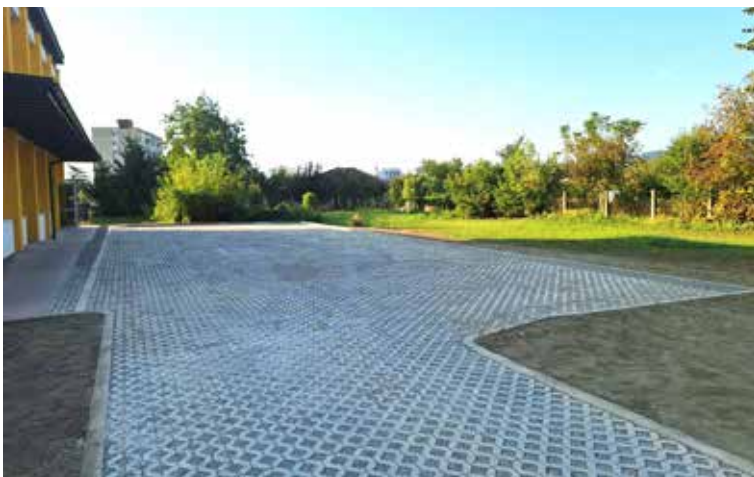
Prístupová komunikácia a parkovisko pri Jasliach Margitka
