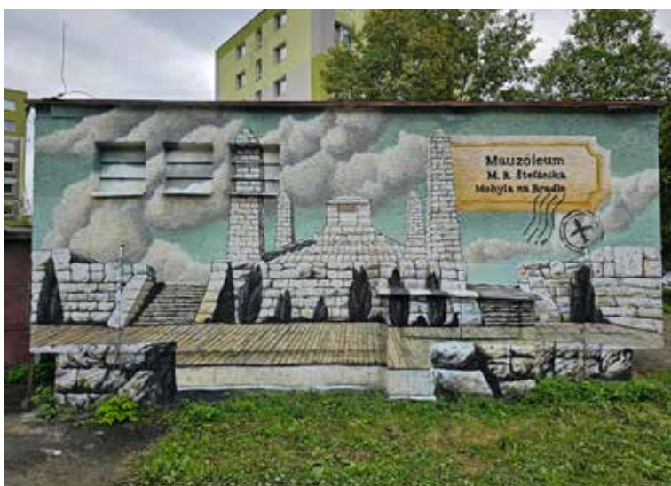
Trafostanica na ulici Okružná
